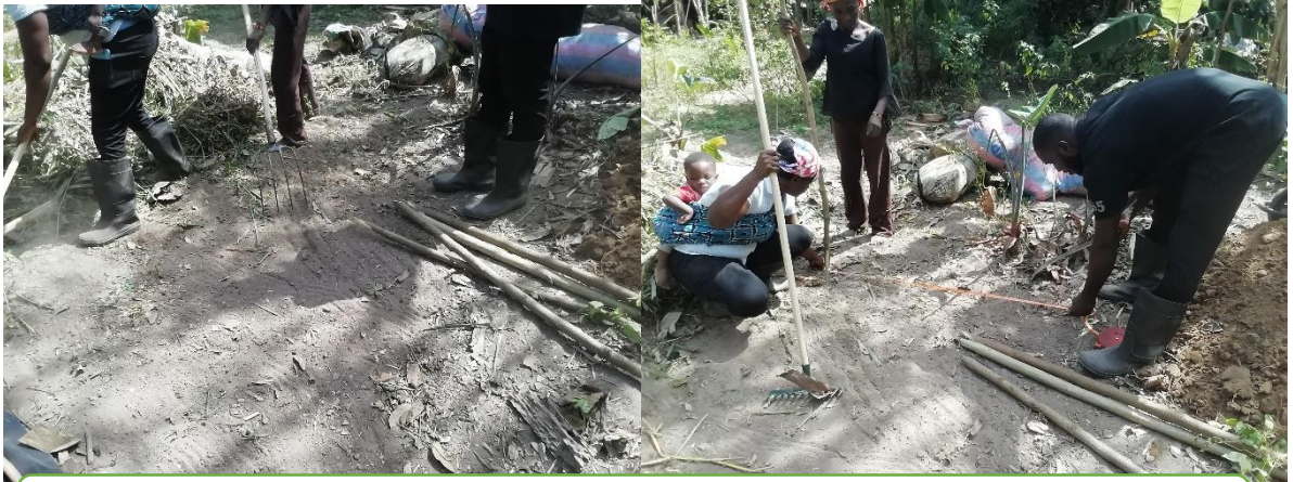
Préparation du site
